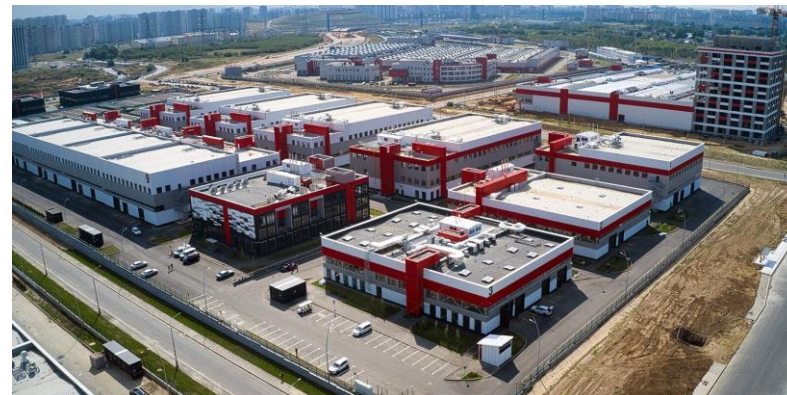
Строительство шести новых зданий 建造六座新楼
