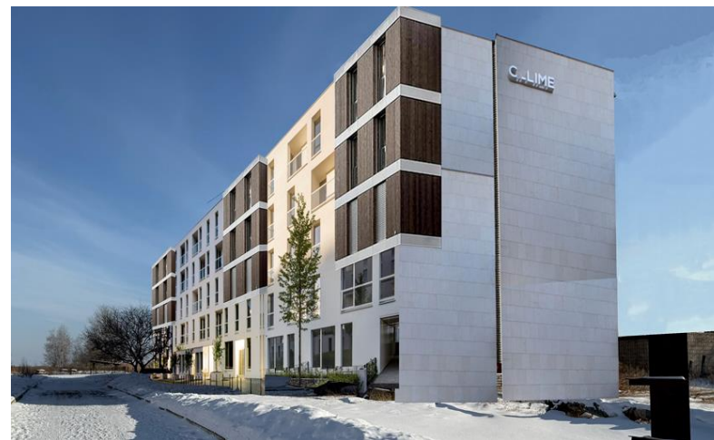
Реконструкция здания бывшей казармы 重建前兵营大楼
