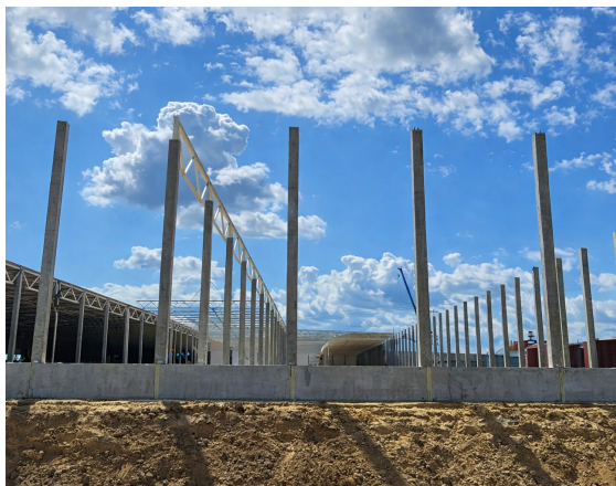
Рис. 4. Цокольные панели заводской готовности.
