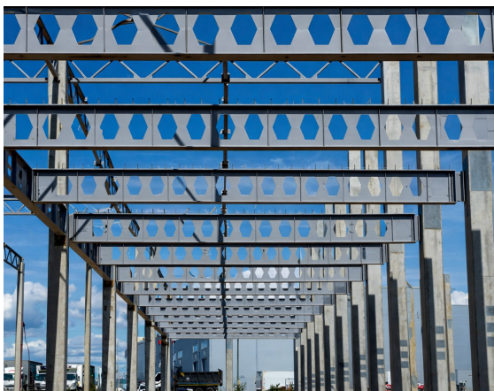
Рис. 6. Перфорированная балка для мезонинов
