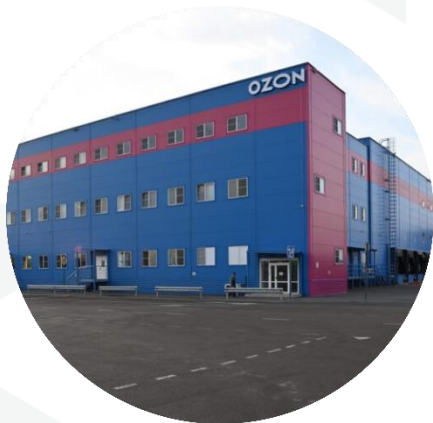
Распределительный центр «Озон»
